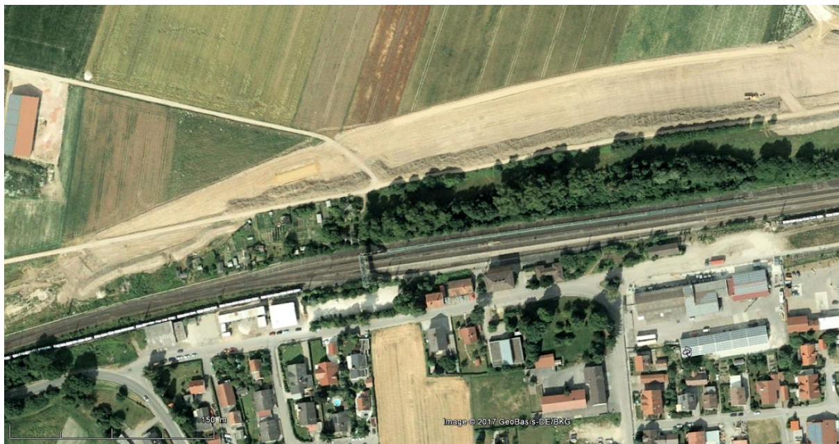
Abb. 2: Google Earth-Luftbild vom Sommer 2010 mit der ursprünglichen Bahnlinie und der Baustelle der westwärts verlegten Trasse (in der Abbildung oberhalb des Gehölzstreifens).
